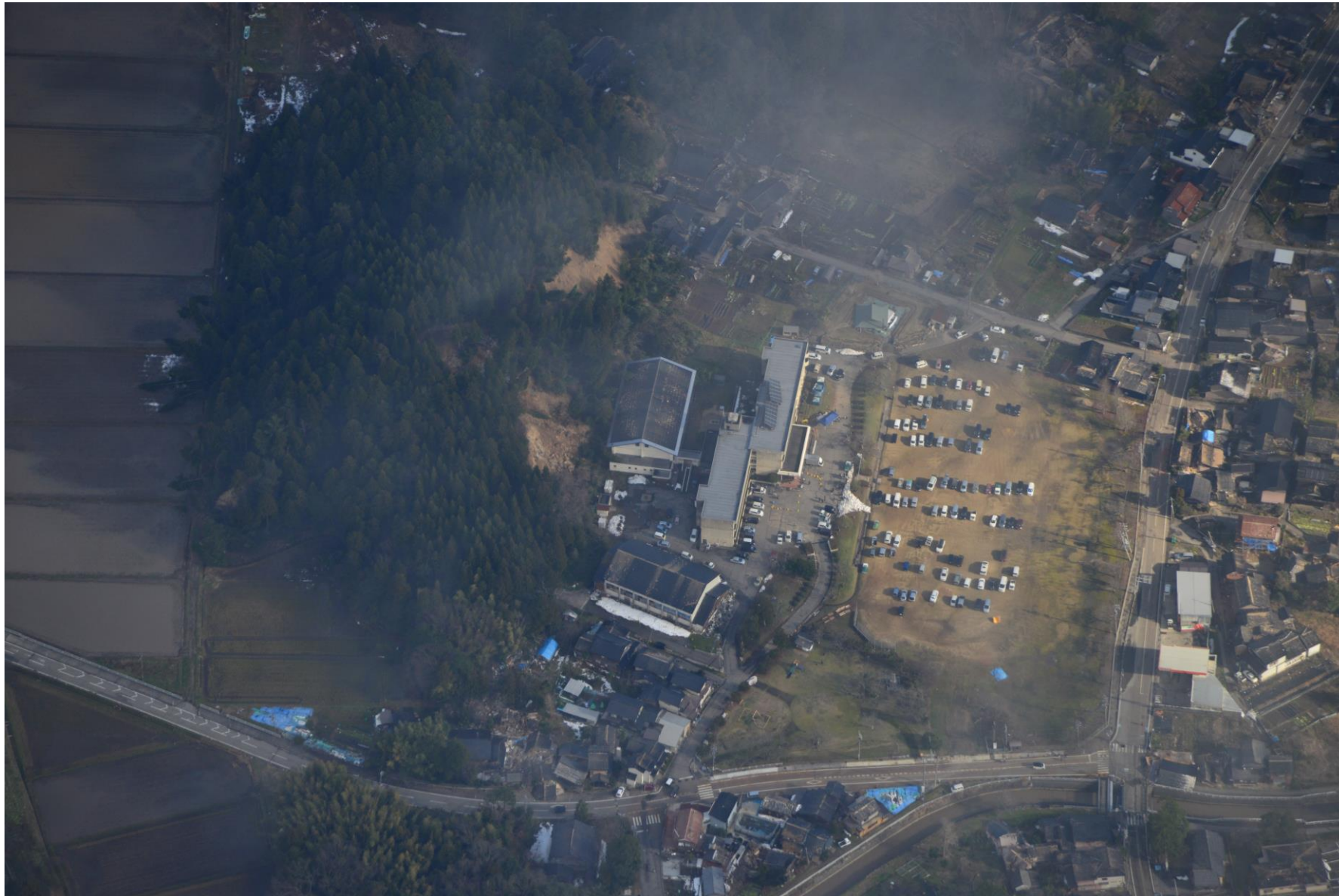
学校の裏山 が斜面崩壊
